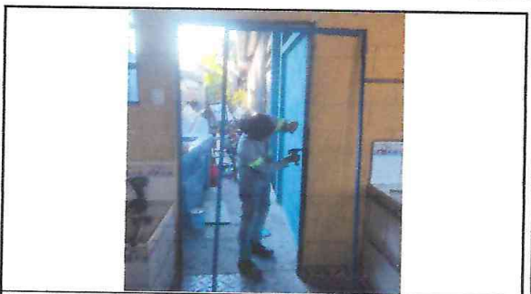
Foto 4: Durante la colocación del cedazo en las puertas
