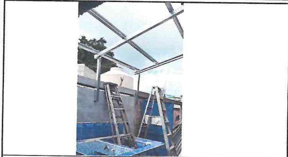
Foto 1: Durante el armado del techo
