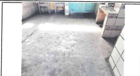
Foto 2: Nivelación de piso de concreto en mal estado y en condiciones no óptimas para el almacenamiento y preparación de alimentos, instalación de mesa de concreto para preparar y servir alimentos.
