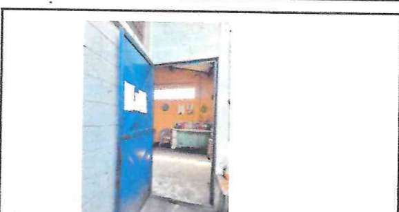
Foto 4: Las puertas abiertas permiten una ventilación, sin embargo hay libre acceso a insectos infecciosos, por lo que se requiere agregarle cedazo a las dos puertas en la cocina.
