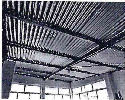
Foto7: Estructura de techo
