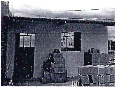
Foto 3: Continuidad de cocina
