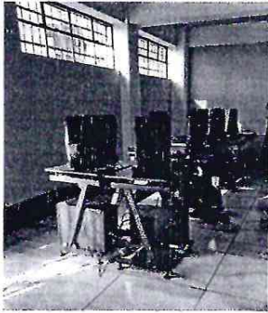
Foto1: Reparación de sistema eléctrico
