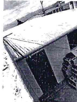
Foto 8: cubierta de lámina
