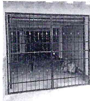
Foto 4: Sustitución de portón de rejas
