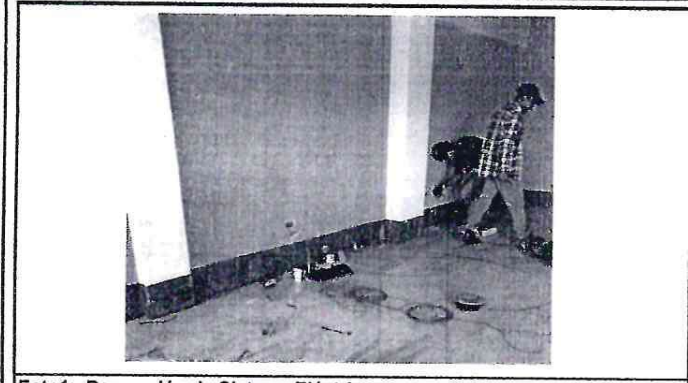
Foto1: Reparación de Sistema Eléctrico
