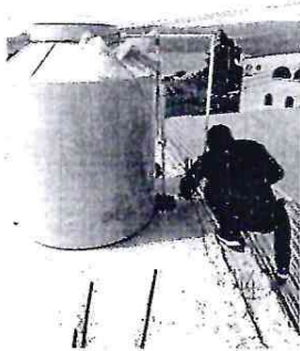
Foto 9: Reparación y mantenimiento de cisterna/depósito de agua
