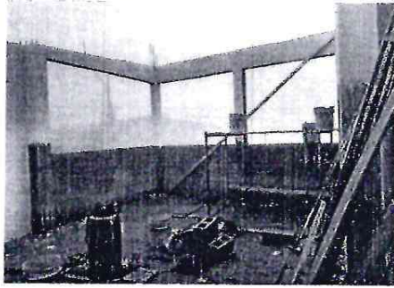
Foto 7: Estructura de techo
