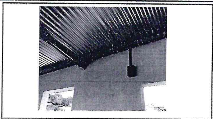
Foto 2: Reparación de Sistema eléctrico (cocina)
