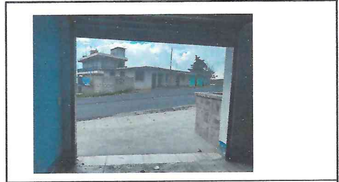
Foto 4: Sustitución de puerta de rejas
