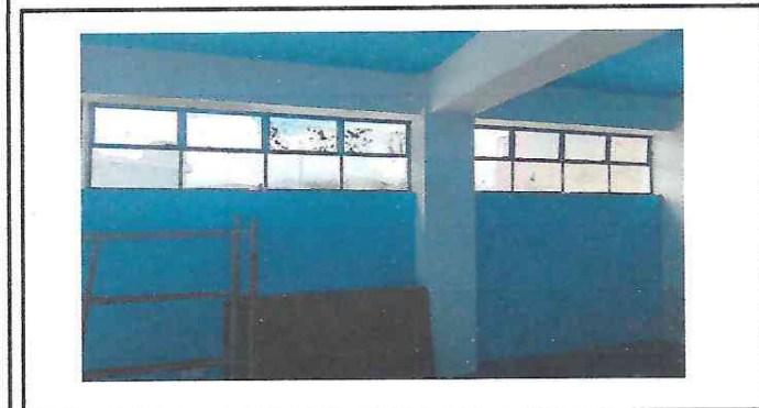
Foto 3: Sustitución de balcón
