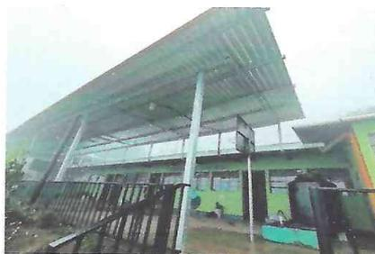
Foto 4: Canales y bajadas de agua pluvial
