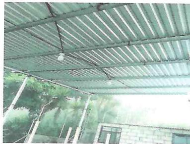
Foto 2: Sustitución de parales de PVC y costaneras de madera
