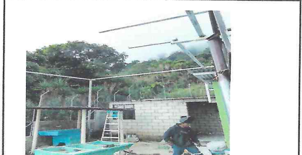
Foto 2: Sustitución de parales de PVC y costaneras de madera
