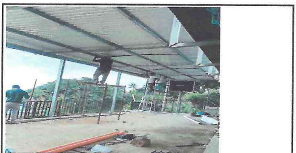
Foto 3: Instalación del sistema eléctrico
