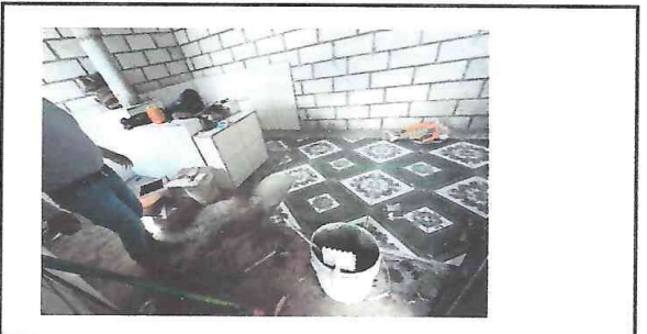
Foto 5: Sustitución de piso de cemento.
