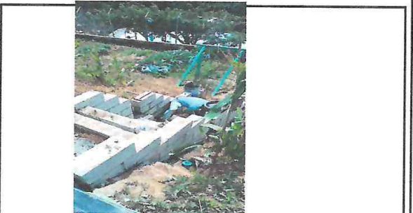
Foto 6: Continuidad del muro perimetral para seguridad de los niños.
