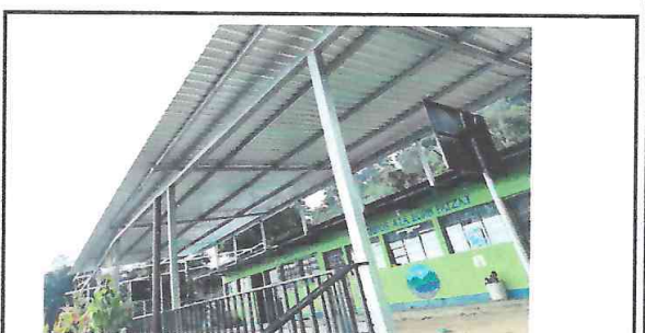
Foto 4: Canales y bajadas de agua pluvial
