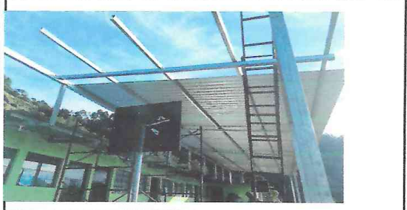
Foto 1: Estructura de techo de patio
