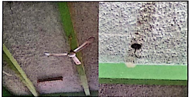
Foto 4: Reparación del sistema eléctrico y cambio de accesorios.
