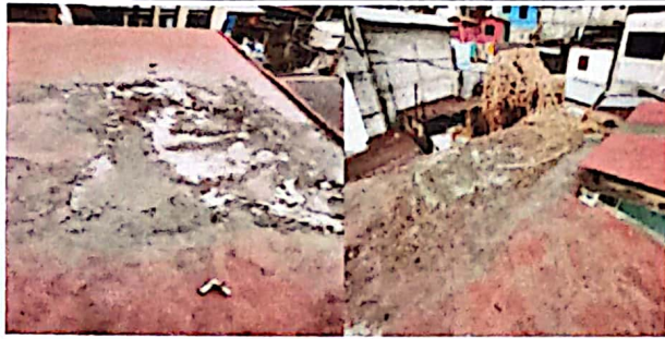
Foto 1: reparación de Loza e Impermeabilización
