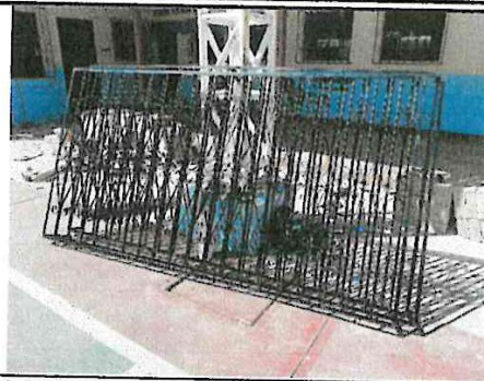
Foto 2: Trabajando los balcones para las ventanas
