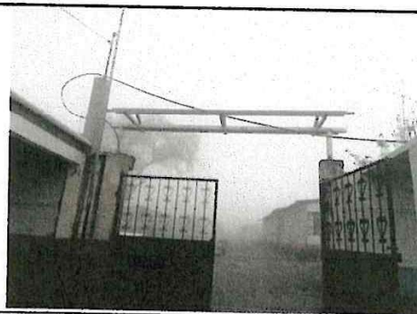
Foto 4: Trabajando el mantenimiento del portón y el techo
