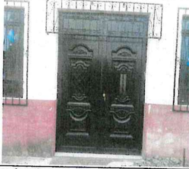
Foto 1: Colocando ya la puerta de metal
