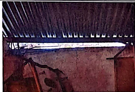
Foto 6: Reparación de repello y cernido de paredes
