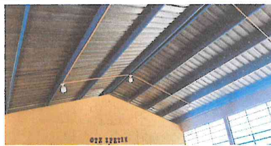
Foto 4: Reparación de sistema eléctrico, (focos y plafoneras)
