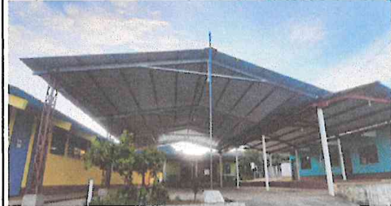
Foto 2: Continuación de la estructura de metal con cubierta de lámina.
