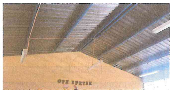
Foto 4: Reparación de sistema eléctrico, (focos y plafoneras)
