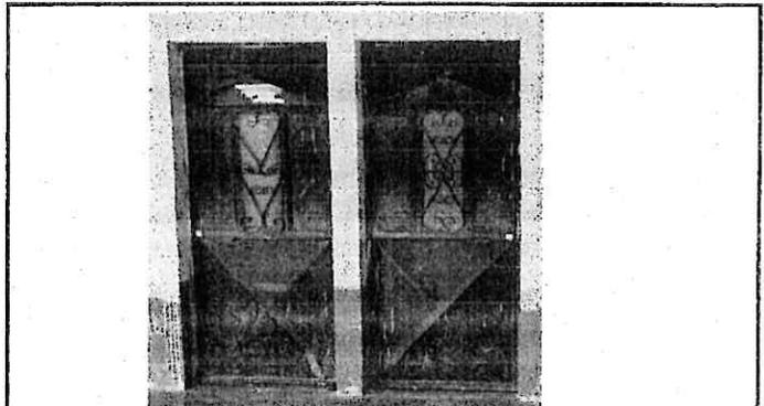
Foto 2: Cambio de puertas de metal por deterioro y defectos en las chapas
