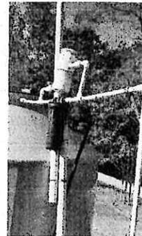
Foto 12: Susutitución de accesorios de depósito de agua
