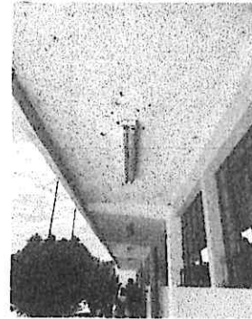
Pintura de muros exteriores e interiores
