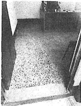
sustitución de piso cerámico
