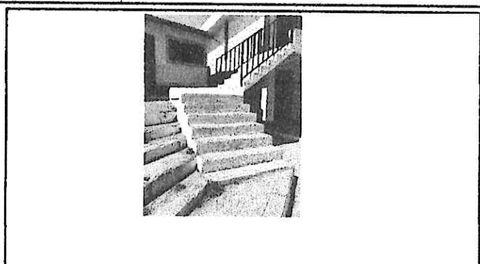
Mantenimiento de baranda.
