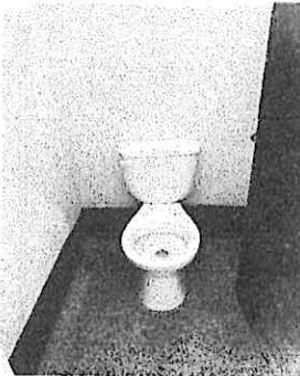
Sustitución de accesorios e inodoro (contrallave, tubo de abasto y tanque)
