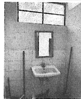
Sustitución de lavamanos.
