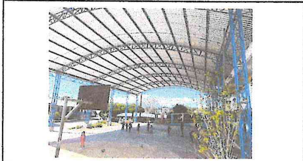
En esta fotografía observamos la el techado finalizado y utilizado por los niños y docentes.
