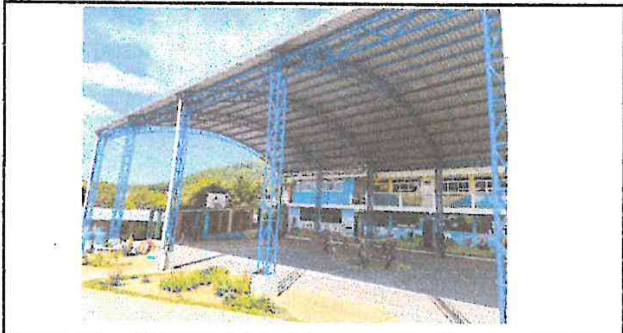
En esta fotografía observamos la el techado finalizado y utilizado por los niños y docentes.
