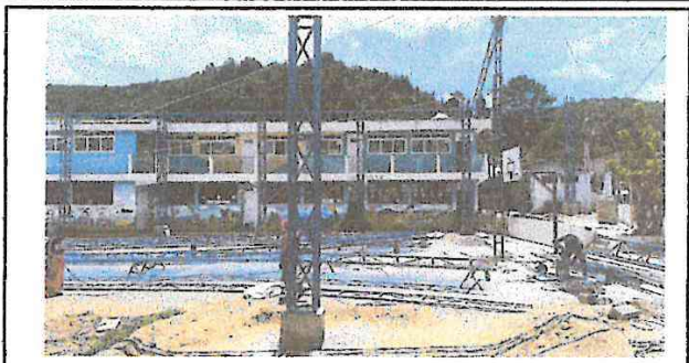
En esta fotografía, observamos ya los arcos que sostendrá la lámina troquelada
