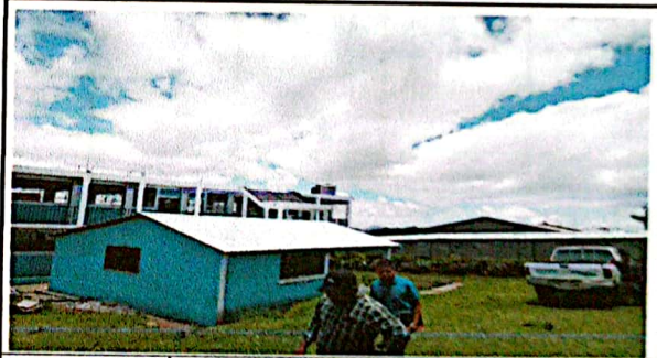
Foto 10: INSTALACIÓN DE LAMINA TROQUELADA EN MÓDULO 2
