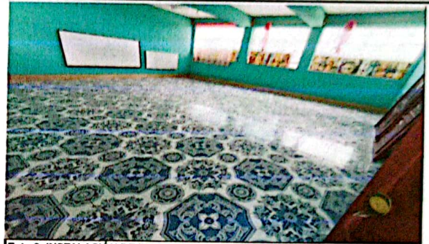
Foto 8: INSTALACIÓN DE PISO CERAMICO EN AULAS
