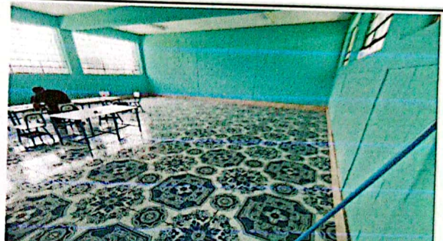
Foto 2: INSTALACIÓN DE PISO EN AULAS E INSTALACIÓN DE ZOCALO
