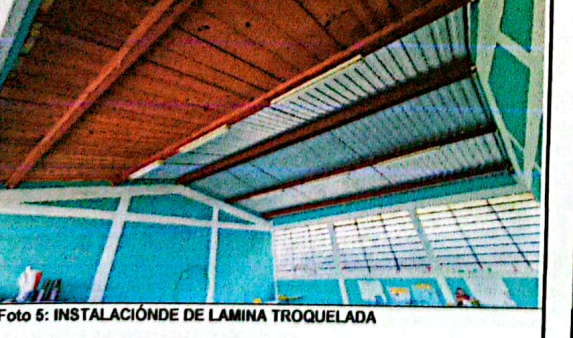
Foto 5: INSTALACIÓN DE LAMINA TROQUELADA
