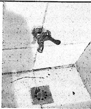
Foto 3: Cambio de chorros en mal estado para evitar fugas de agua
