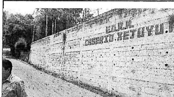
Foto: Pintura en muros exteriores
