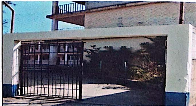
Foto 6: En la actualidad el portón principal no tiene techado, por lo que se le colocara techo para prolongar su duración.
