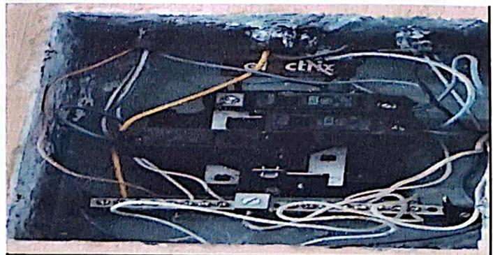
Foto 18: Sustitución de Filpones, debido a que se encuentran sobrepuestos.
