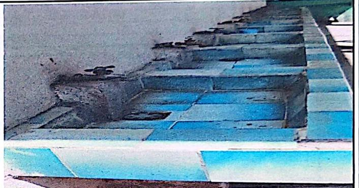
Foto 14. Llaves de choros que serán sustituidas por tener mal funcionamiento.
