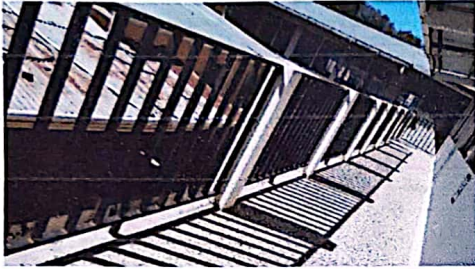
Foto 7: Mntenimiento de barandas.
