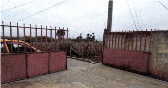
Foto 7: PORTON EN MAL ESTADO CON CORROSIÓN Y CAÍDO
