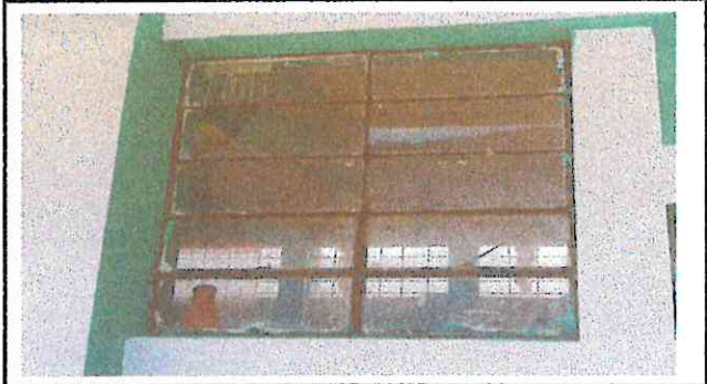
FOTO: SUSTITUCIÓN DE VENTANAS.
