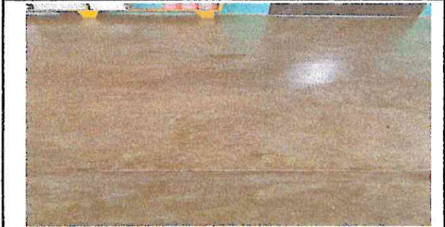
FOTO 4: SUSTITUCIÓN DE PISO.
