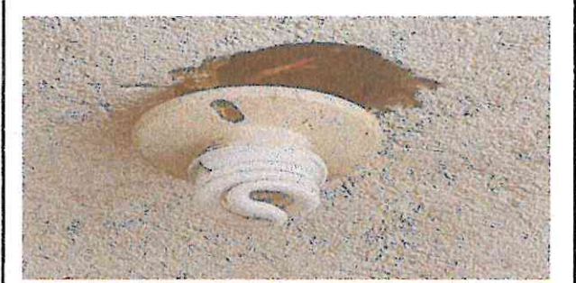
FOTO 6: SUSTITUCIÓN DE PLAFONERAS.
