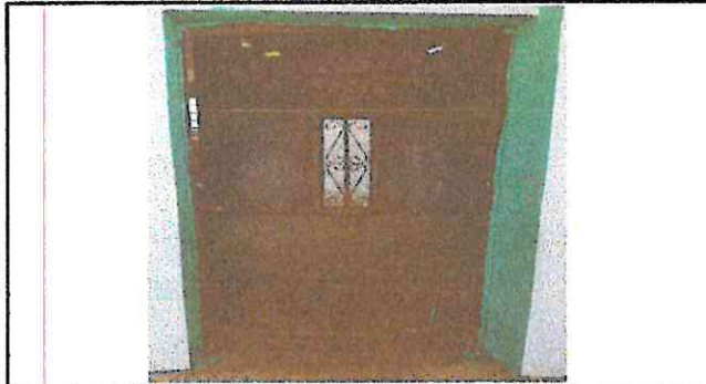
FOTO 1: SUSTITUCIÓN DE PUERTA DE METAL A METAL
