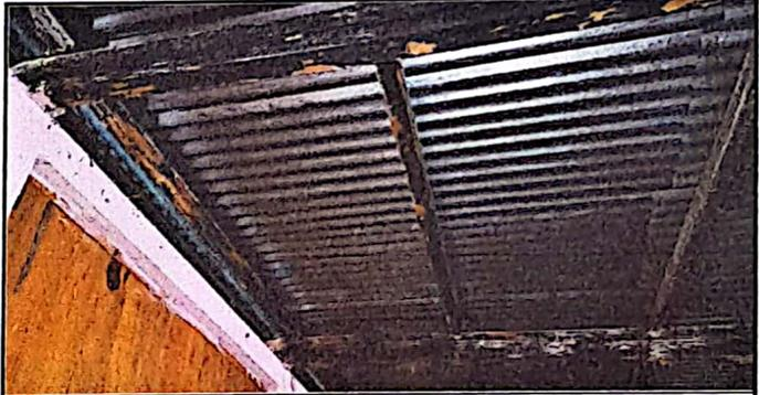
Foto 4: Deterioro de la madera utilizada como soporte para el techo
