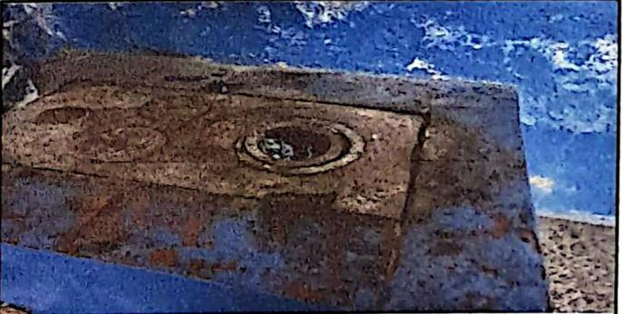
Foto 6: Se necesita cambio de Plancha en el área destinada a cocina.
