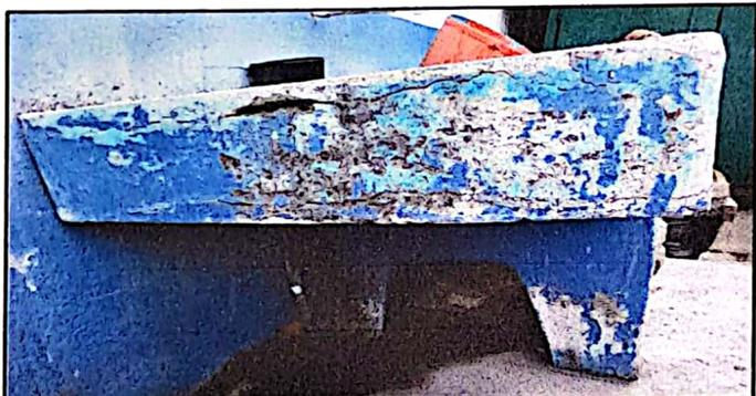
Foto 3: Deterioro en pila, presenta agrietamiento en su estructura.
