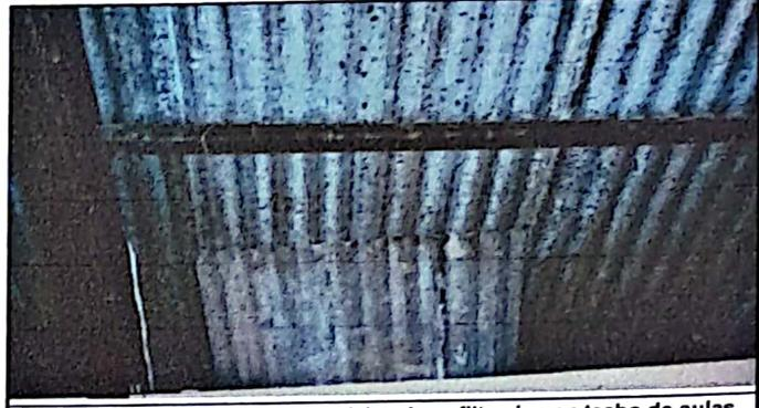
Foto 2: Colocacion de lamina provisional por filtracion en techo de aulas planta alta del centro educativo.
