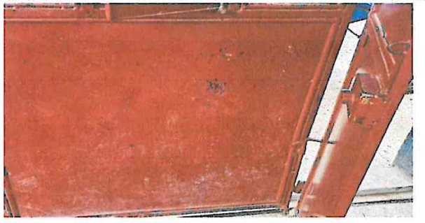
Foto 4: Cambio de puerta por deterioro.
