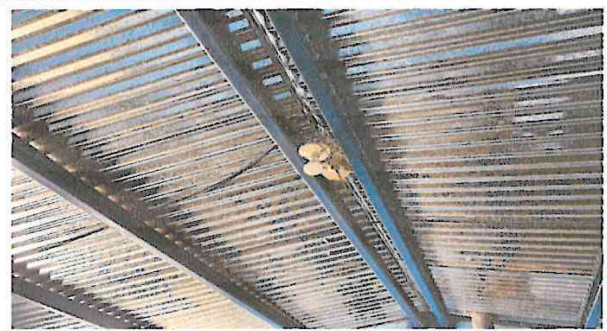
Foto 2: Reparación de sistema eléctrico por falta de funcionamiento.
