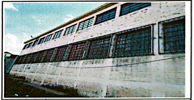
Foto 10: INSTALACIÓN DE BALCONES DE METAL EN ESTABLECIMIENTO
