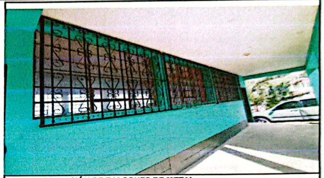
Foto 8: INSTALACIÓN DE BALCONES DE METAL
