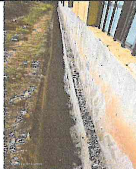
Foto 2. Sigue el proceso del trabajo de la cuneta.
