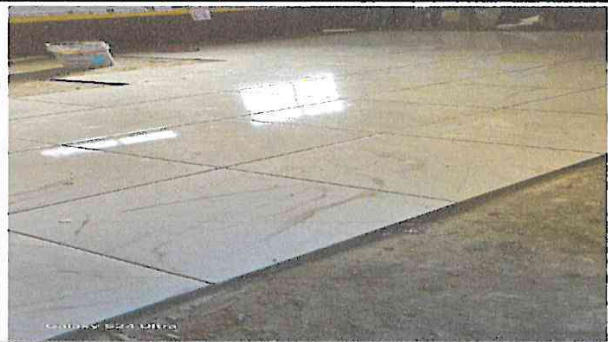
Foto 1. El trabajo de la colocación de piso cerámico sigue su proceso.
