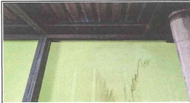
FOTO No. 3 Filtración de agua en techos de la cocina.
