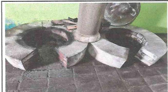
FOTO No. 3 Estufa en mal estado de la cocina.
