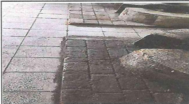
FOTO No. 1 Estufa dañados por filtracion de agua
