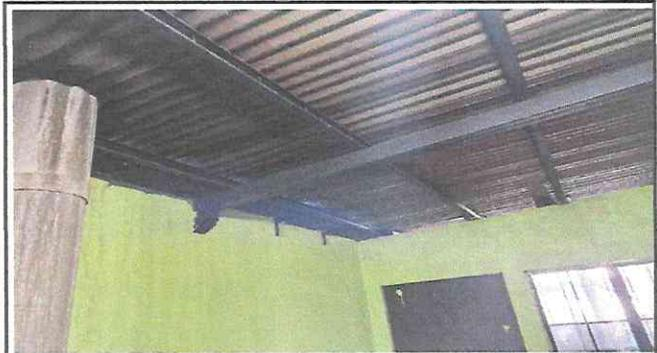
FOTO No. 4 Filtración de agua en techos de la cocina.
