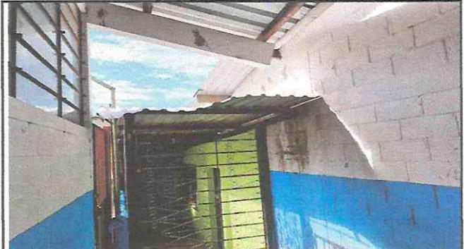
FOTO No. 2: Lamina de ingreso en mal estado de la cocina.
