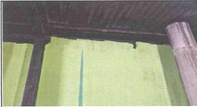
FOTO No. 1 Filtración de agua en techos de la cocina.
