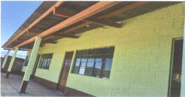
Foto 3: Canal y bajadas de agua pluvial
