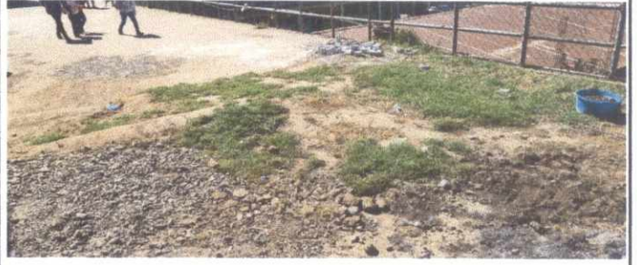
Foto 2: Losa de patio
