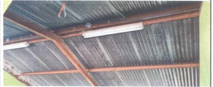
Foto 4: Reparación de Sistema eléctrico
