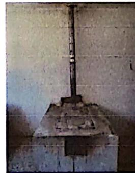
Foto 6: Reparación de estufa rural, colocación de azulejos, cambio de plancha de tres homillos y cambio de tubos de chimenea.
