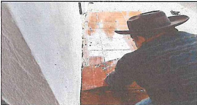
Foto 3: Colocación de pisos en el corredor de la cocina
