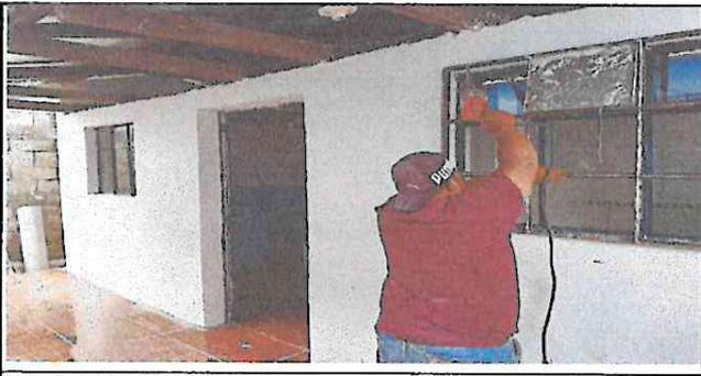
Foto 5: Colocación de puertas y ventanas
