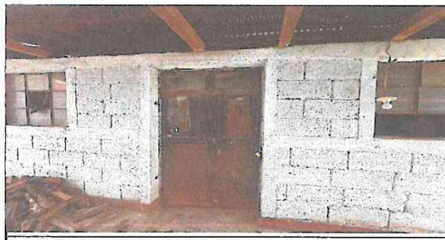
Foto 5: Puertas y ventanas deteriorados
