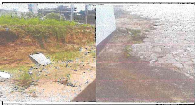
Foto 6: Muro de contención en malas condiciones
