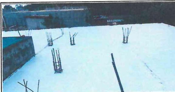
Foto 3: Terminación de impermeabilización de las tres aulas.
