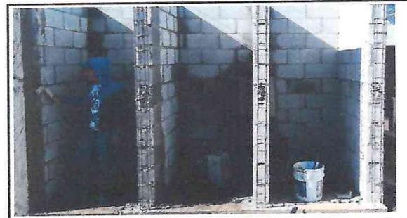
Foto 4: culminación de la reparación de pared de las tres aulas
