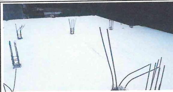
Foto 1: impermeabilización terminada al cien por ciento.
