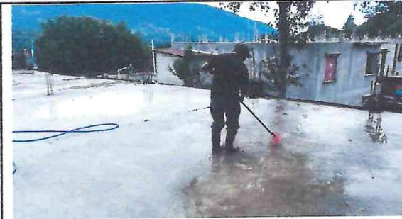
Foto 1: Lavado de loza, para la impermeabilización para que no filtre agua en las aulas, para la mejor atención de los niños.
