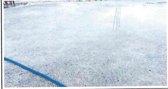
Foto 2: Limpieza total de la loza, para la impermeabilización
