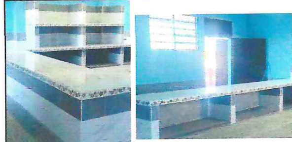
FOTO 6: Terminación de mesa de concreto y alacena.
