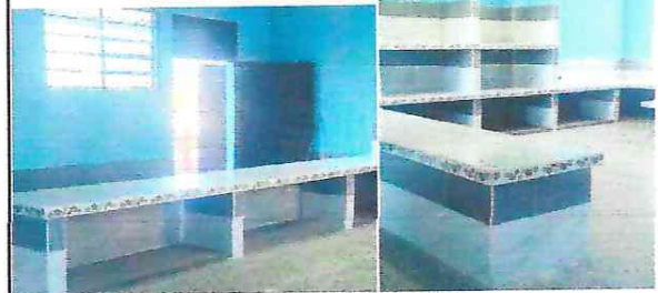
FOTO 4: Terminación de mesa de concreto y alacena.
