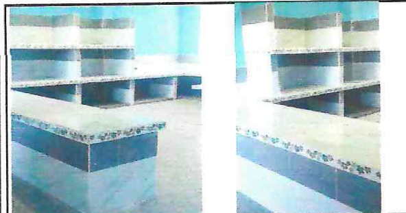
FOTO 5: Terminación de mesa de concreto armado
