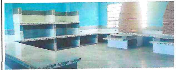
FOTO 3: Terminación de cocina escolar.
