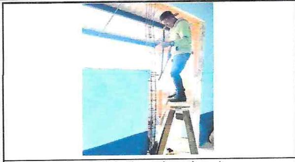
FOTO 8: Inicialmente se muestran trabajos de armado para la puerta.
