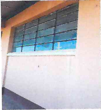
Foto 7: Espacio donde se necesita abrir otra puerta.
