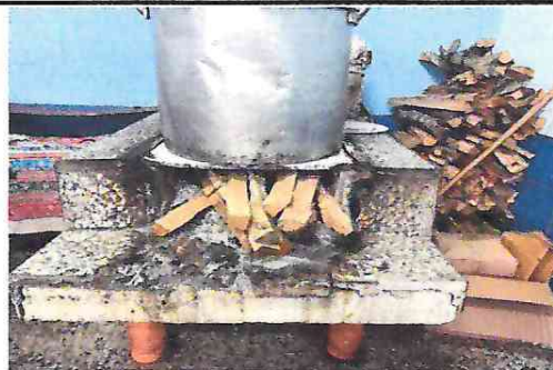
FOTO 2: La estructura de las comaleras fisuradas.
