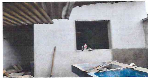
Foto 3: Avance de puerta de metal y repello
