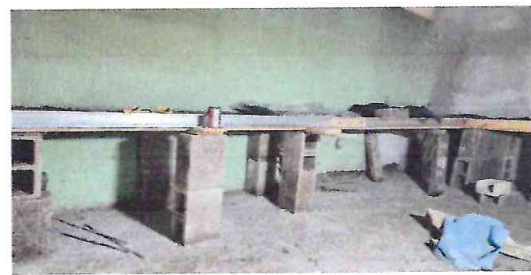
Foto 4: Avance en sustitución de pila de cemento
