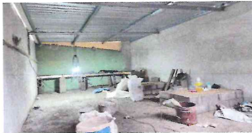
Foto 5: Avance en sustitución de piso cerámico
