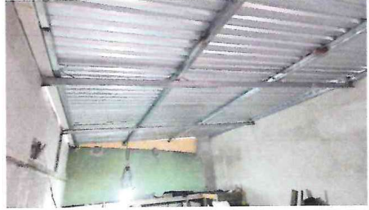
Foto 2: Avance en sustitución de lamina troquelada
