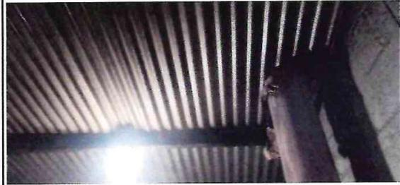
Foto 2: Sustitución de lámina por lámina troquelada
