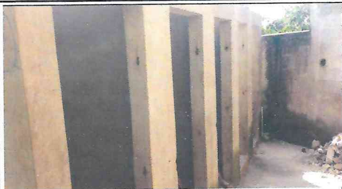
Foto1: Sustitución de puertas de Servicios Sanitarios
