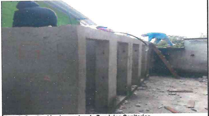
Foto 2: Sustitución de puertas de Servicios Sanitarios
