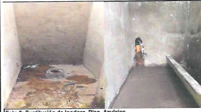
Foto 3: Sustitución de Inodoro, Piso, Azulejos...
