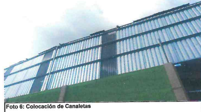
Foto 6: Colocación de Canaletas
