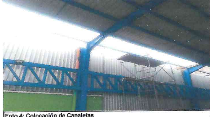
Foto 4: Colocación de Canaletas
