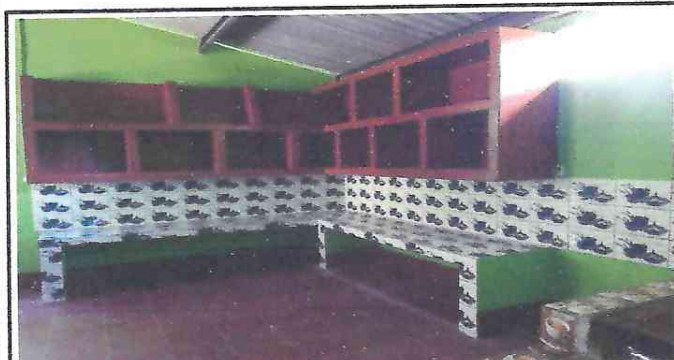
Foto 3: pared en la cocina ya con gabinetes.
