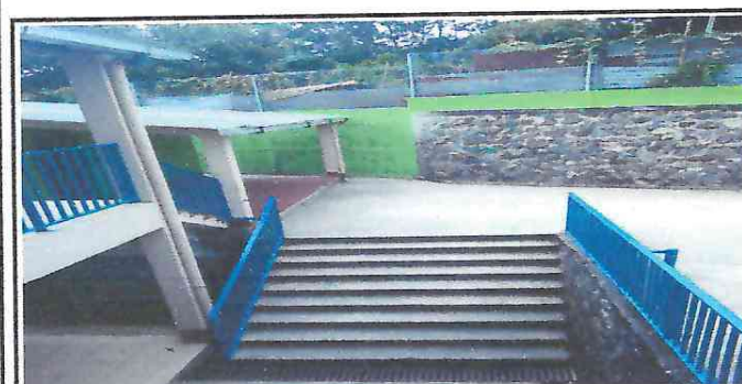
Foto 5: muro frente las aulas ya pintadas.
