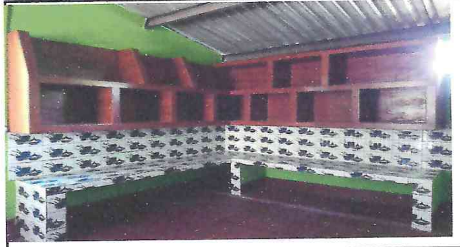
Foto 4: cocina ya construida las Gabinetes.
