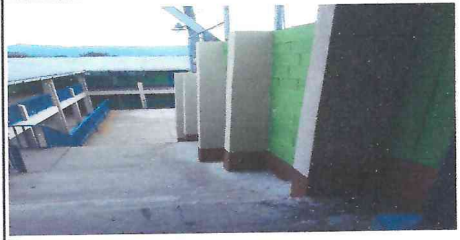
Foto 2: muro perimetral y aulas ya pintado.
