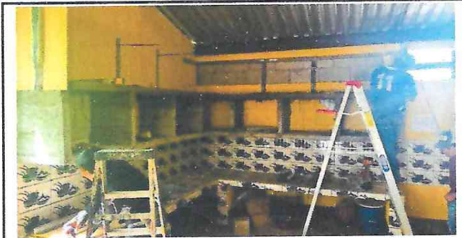
Foto 4: Terminada la estantería se le colocara azulejo.
