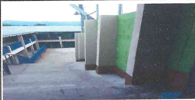
Foto 2: muro perimetral y las aulas ya pintada.
