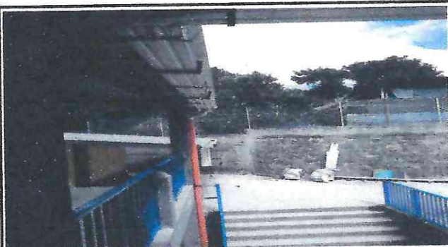
Foto 5: muro frente las aulas que se va pintar.
