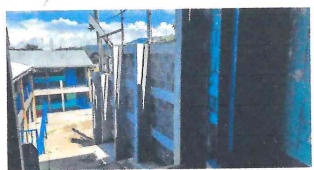
Foto 2: muro perimetral y aulas que se va pintar.
