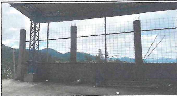
FOTO 1: MANTENIMIENTO DE MURO PERIMETRAL
