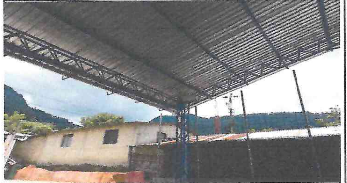
FOTO 2: CONECCIÓN DE ELECTRICIDAD EN LA CANCHA TECHADA
