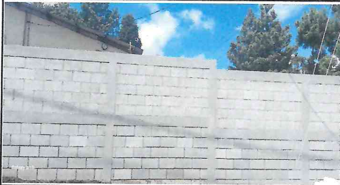
Foto 1: Ampliación muro perimetral
