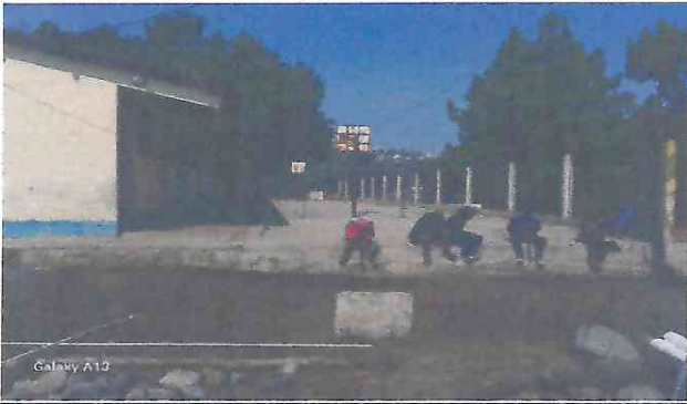
Foto 1: Ampliación de muro perimetral
