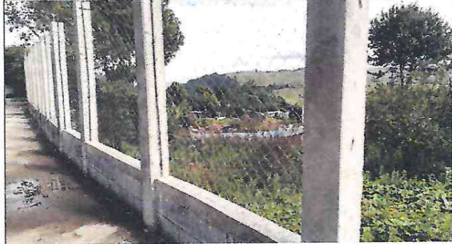
Foto 2: Es así como se ve el muro perimetral de la escuela.
