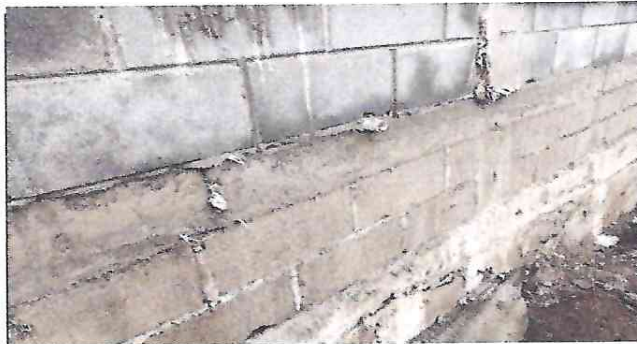
Foto 3: Así quedó la terminación del cimlento del muro perimetral
