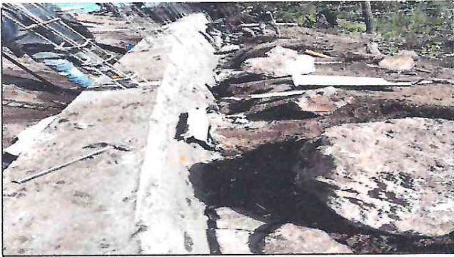
Foto 3: Fundición del cimiento del muro perimetral.
