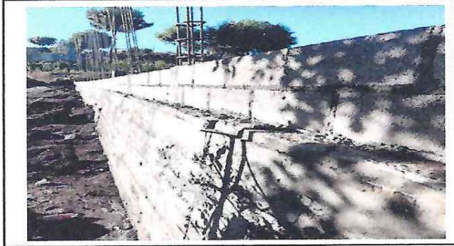
Foto 2: Desarrollo en proceso del trabajo en su colocación de block
