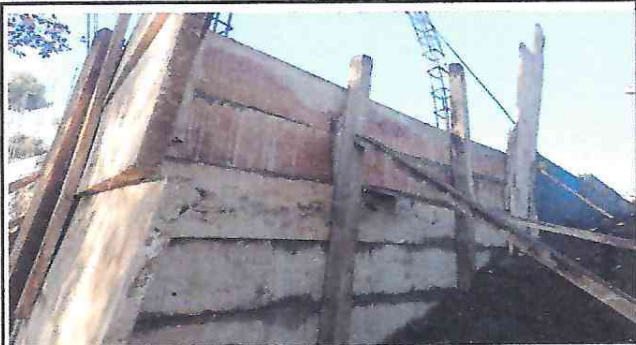
Foto 1: Desarrollo en seguimiento del cimiento del muro perimetral.
