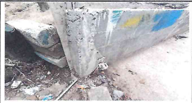
Foto 2: Cimiento de muro perimetral.
