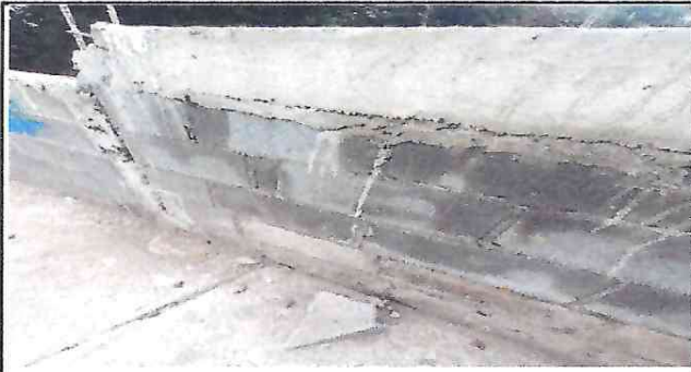
Foto 1: Seguimiento de muro perimetral
