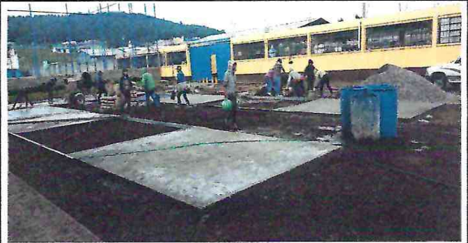
En esta fotogra nos muestra el avance de la fundicion de losa de parte del albañil y ayudante, con esta se esta llevando acabo el armado de cubos en cada parte de la losa.
