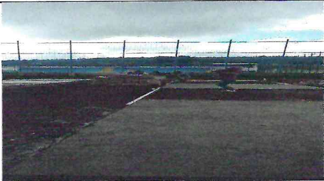
En esta fotografía muestra la fundición de losa realizada por el albañil y ayudantes
