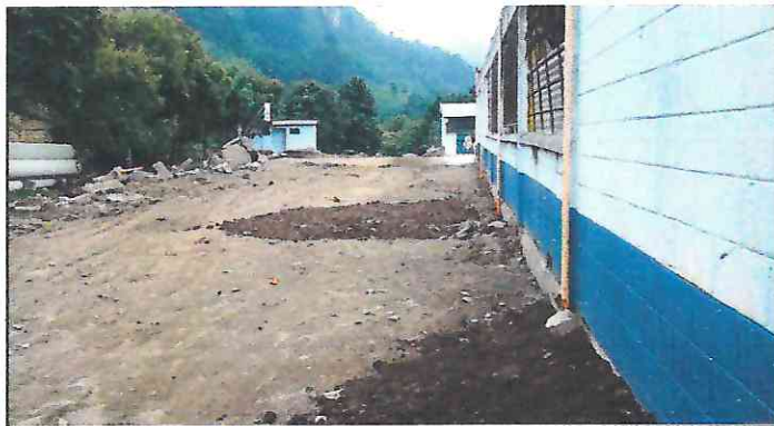
FOTO 3: LIMPIEZA DE ESCOMBROS
