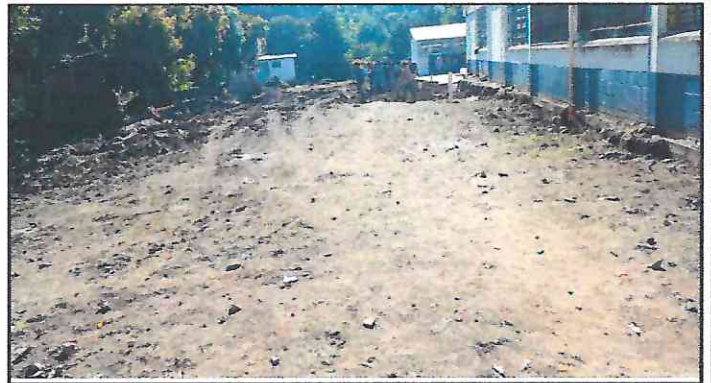
FOTO 4: RETIRO DE ESCOMBROS
